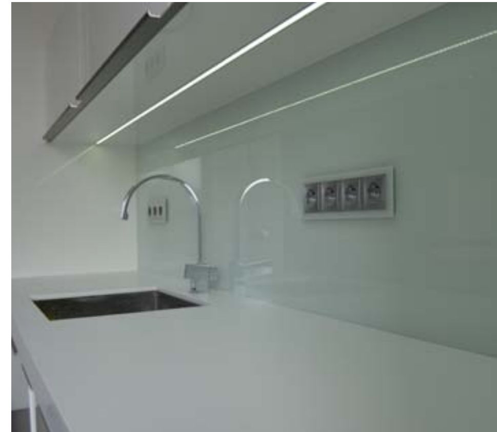
osvětlení pod horními skřínkami: zafrézovaným LED páskem
