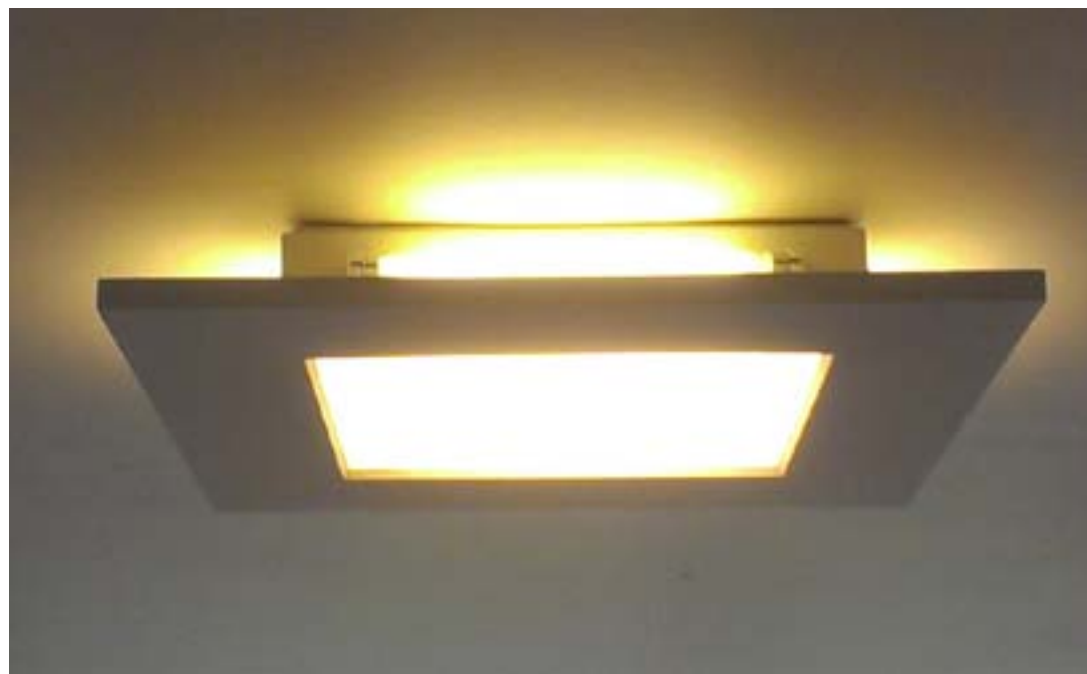
svítidlo stropní do OP - stávající, bílé 60x60cm
