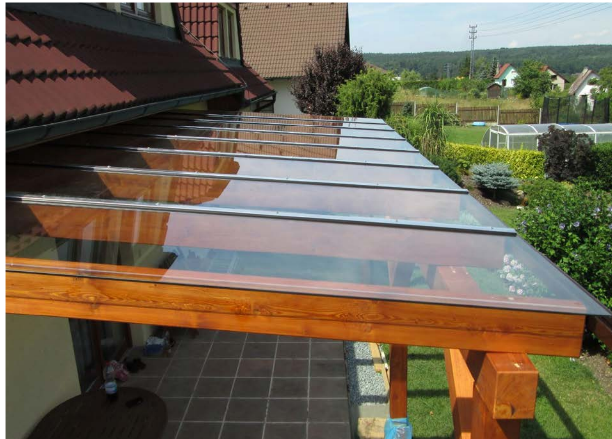
Skleněné zastřešení s podélnými hliníkovými profily
