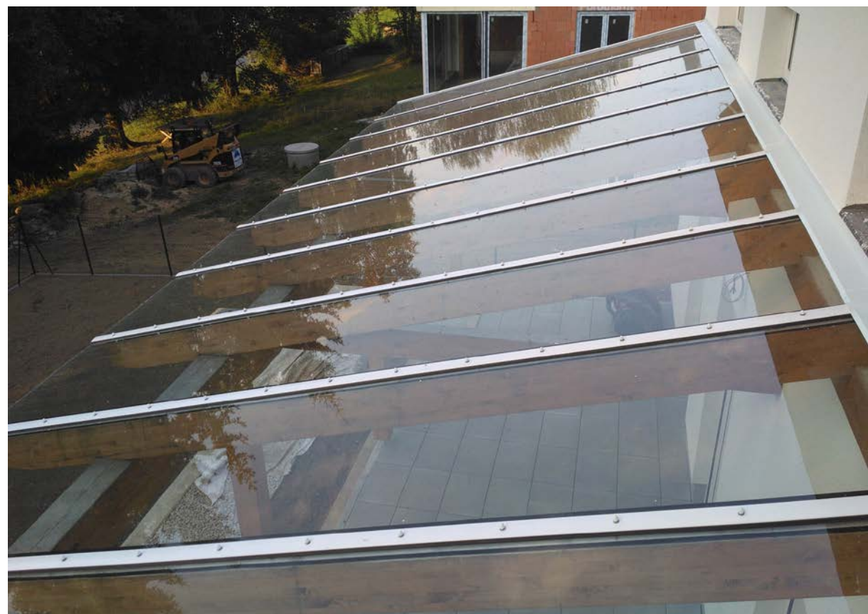
Skleněné zastřešení s podélnými hliníkovými profily
