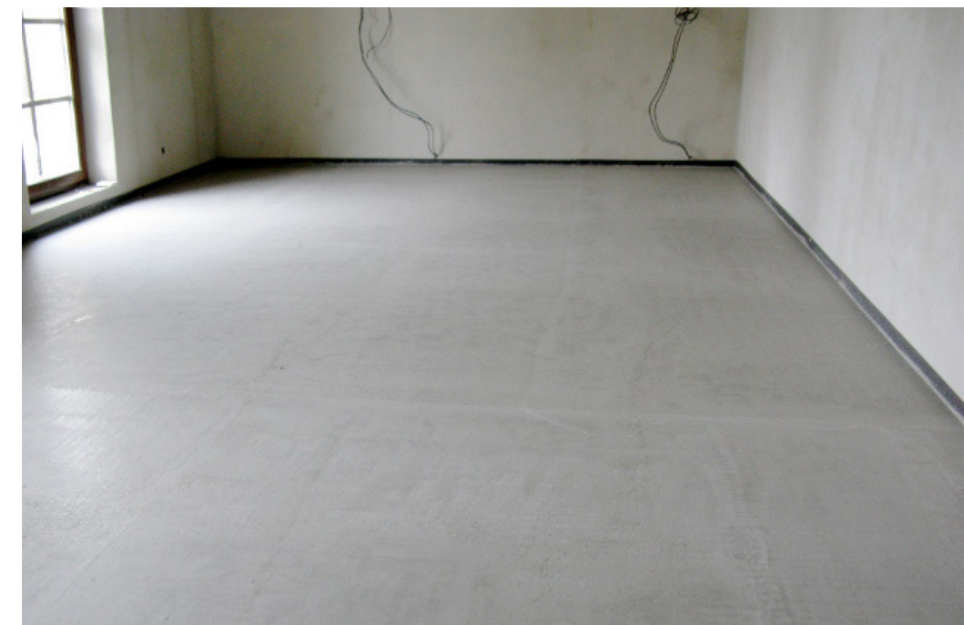
podlaha do koupelny - betonová stěrka
