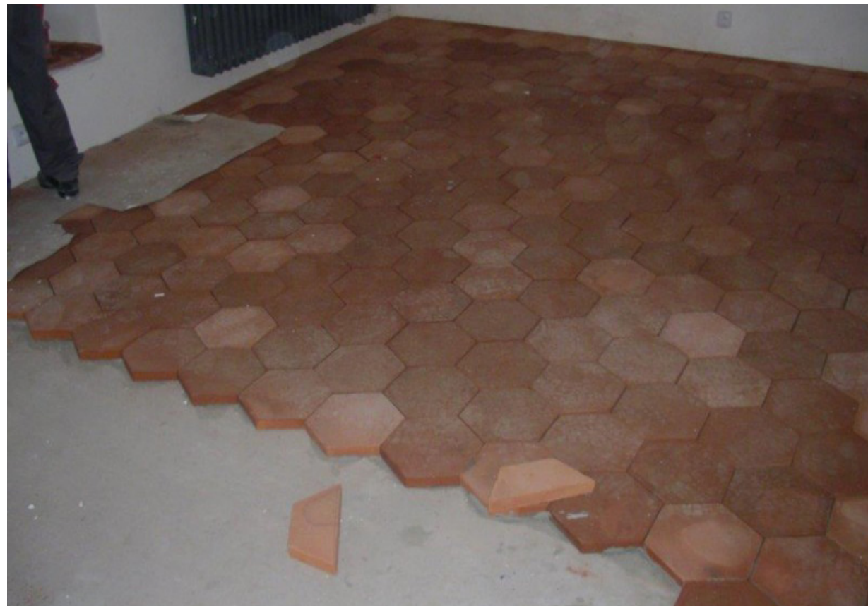
PODLAHA V CHODBĚ A PŘEDSÍNĚ: šestiúhelníková cihlová dlažba
